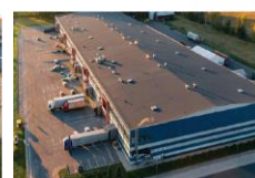
„Dommo business park“ Rīga Latvia
